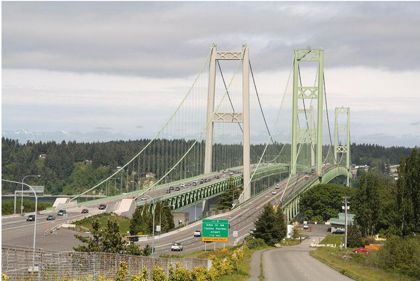
Tacoma (WA) Narrows Bridge, 1940
