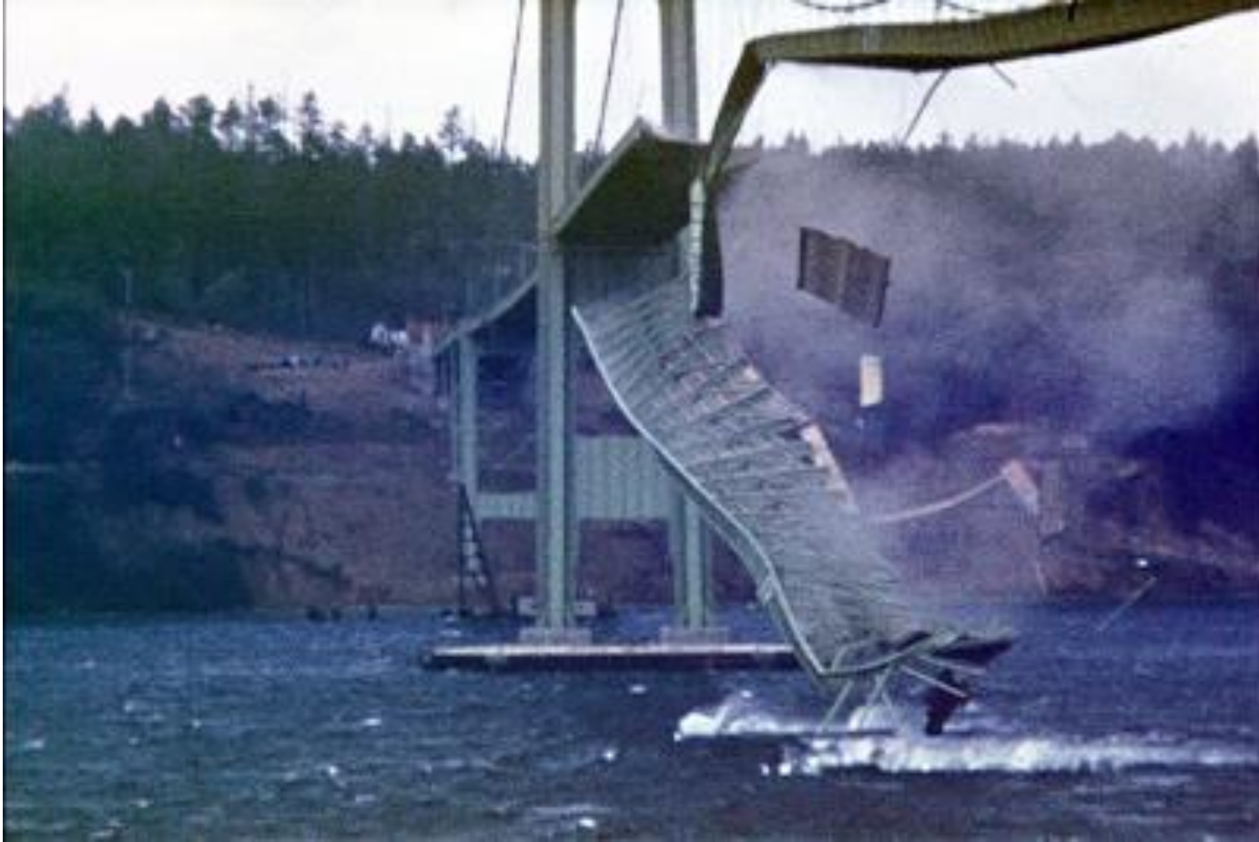
Tacoma (WA) Narrows Bridge, 1940
